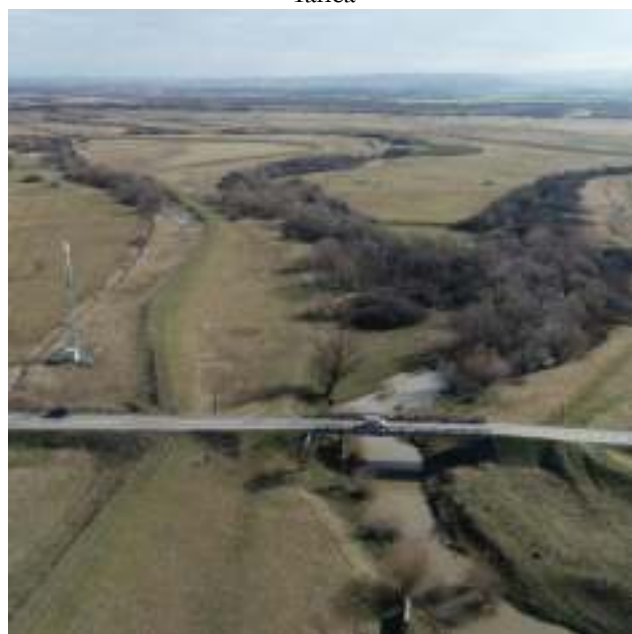
Obiectul 2 – Barcău-Pod DJ767A Saniob
