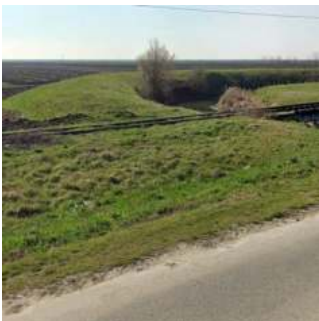
Obiectul 4 - Dig mal stâng râul Crișul Repede, sector pod Tărian - Dig mal drept Canal Colector
