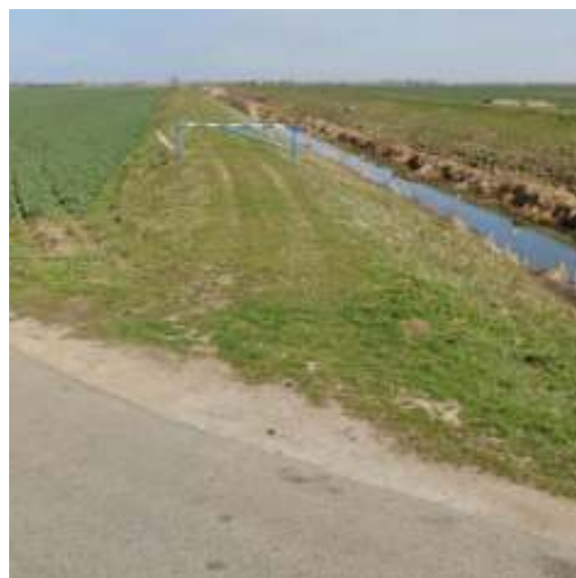
Obiectul 4 - Dig mal stâng râul Crișul Repede
