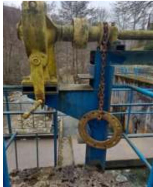
Fig. 11 – Elemente metalice degradate
