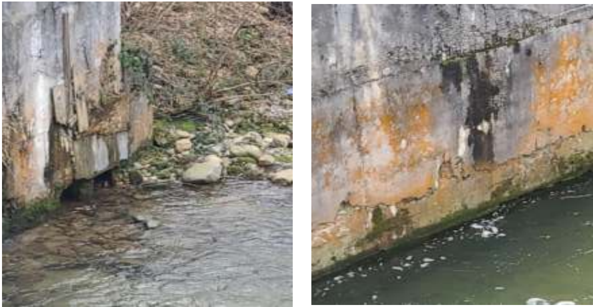
Fig. 9 – Ziduri de sprijin
