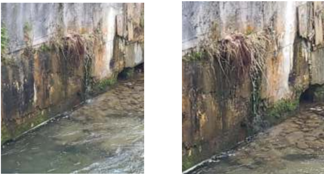
Fig. 10 – Ziduri de sprijin
