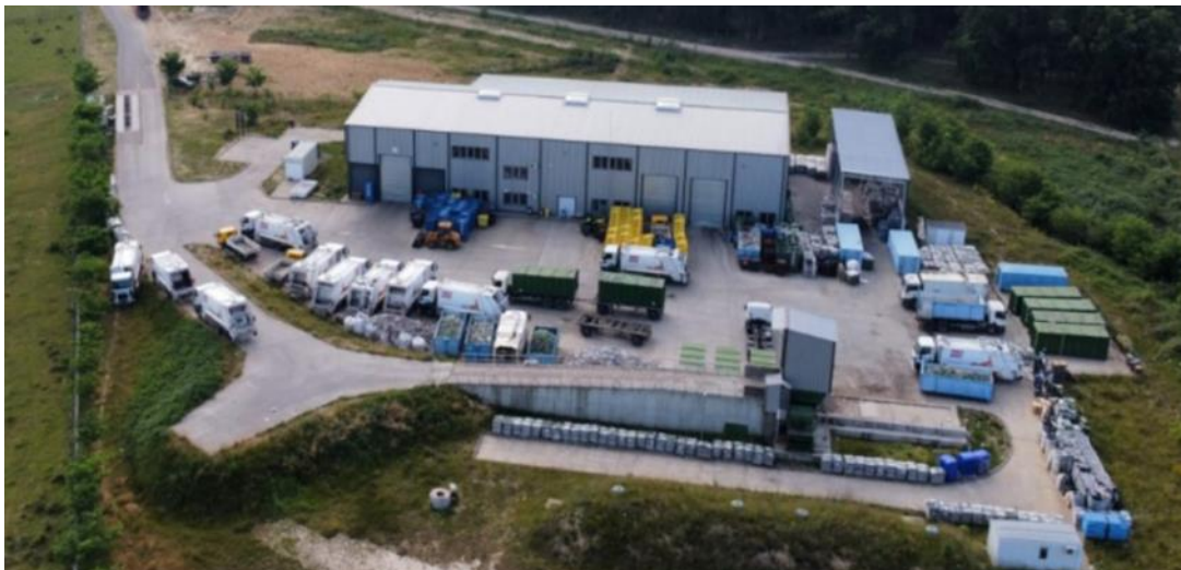
Stația de sortare deșeurilor municipale Salonta – proiect realizat prin SMID Bihor (foto: AVE BIHOR S.A)
