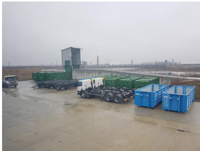
Stație de transfer pentru precolectarea deșeurilor municipale (foto: A.D.I. Ecolect Bihor)
