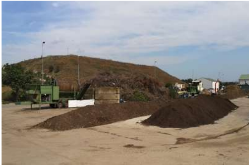
Stație compostare (foto: SC Eco Bihor)
